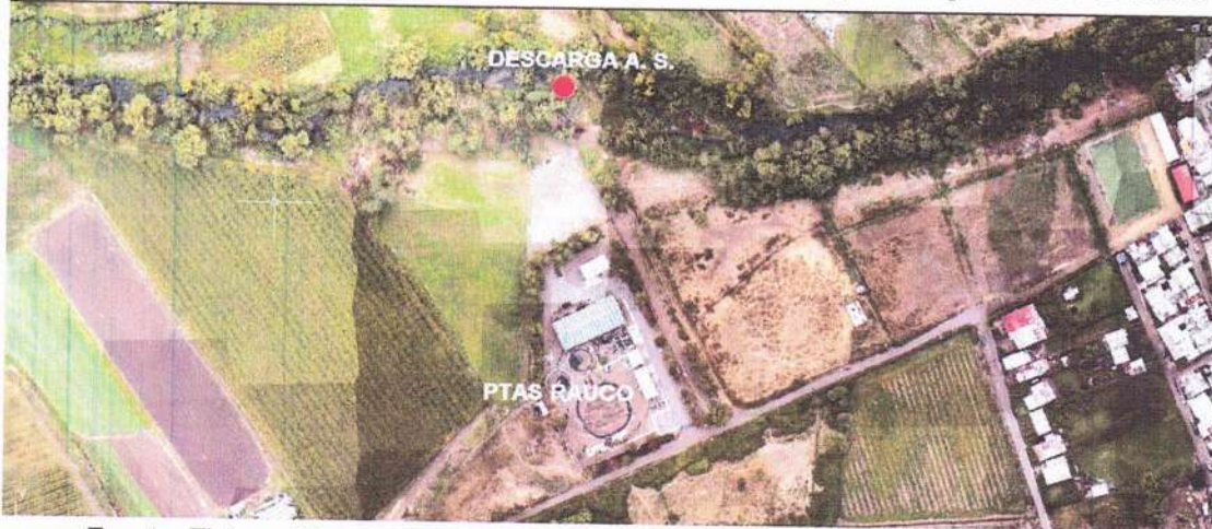
Figura 10. Planta de Tratamiento de Aguas Servidas de Rauco y descarga a estero Comalle.
