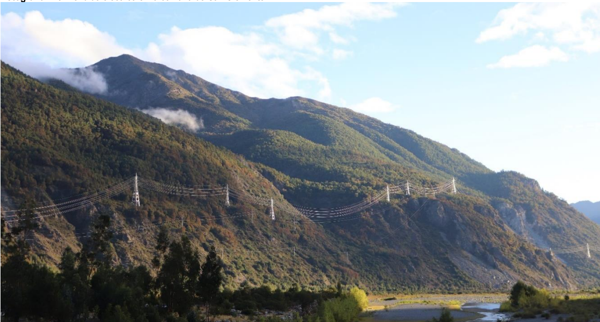
Fotografía N°5: Tendido eléctrico en la comuna de San Clemente
