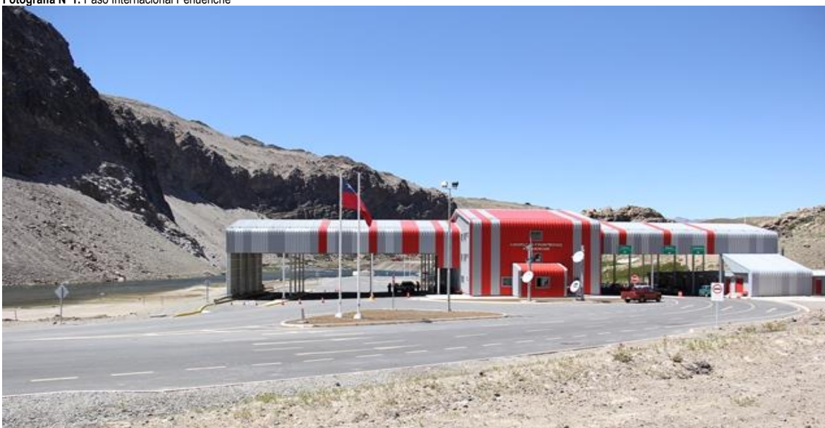
Fotografía N°1: Paso Internacional Pehuenche
