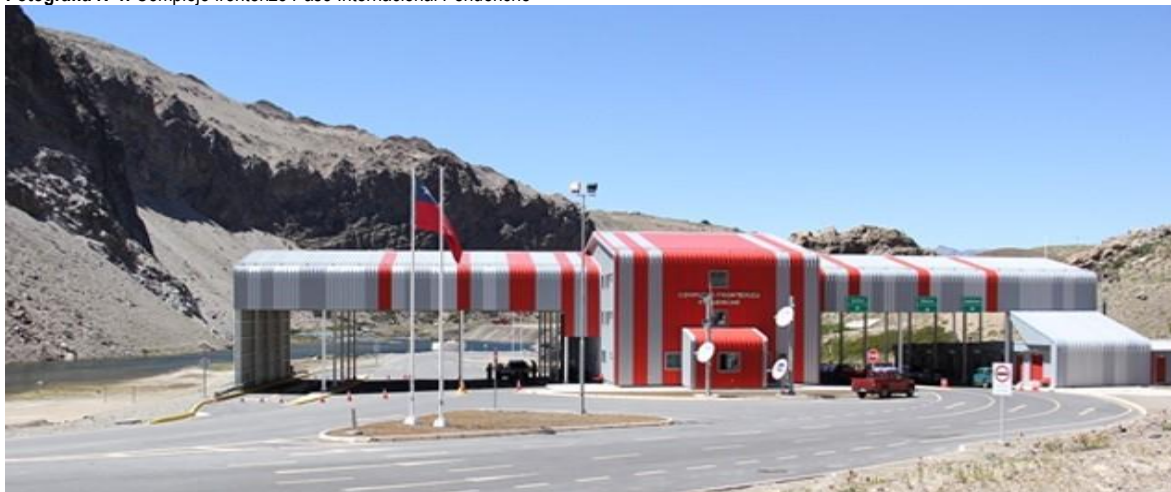
Fotografía N°4: Complejo fronterizo Paso Internacional Pehuenche
