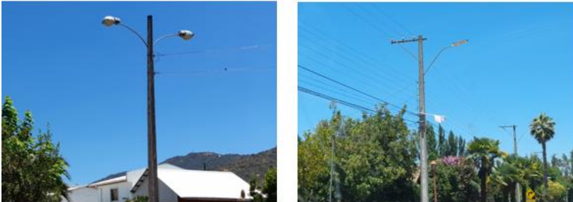
Ilustración 32 y 33: Luminaria pública de sodio de elata presión y LED en la comuna de Rauco
