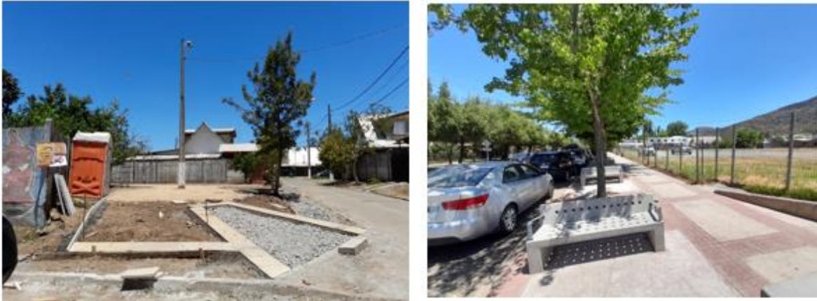
Ilustración 28 y 29: Obras de mejoramiento de áreas verdes y espacio público en la comuna de Rauco
