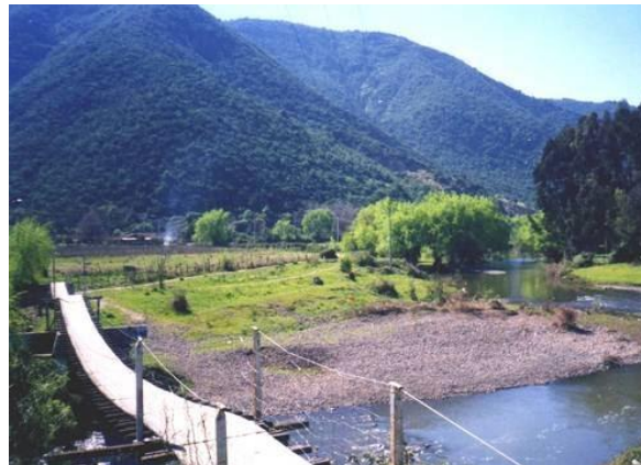
Ilustración 15. Puente de Cimbra comuna de Rauco
