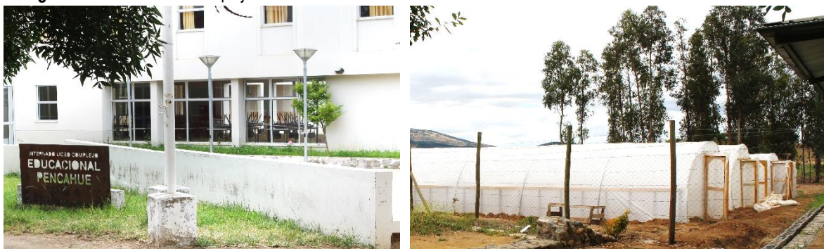
Fotografía N°2: Internado Complejo Educativo
