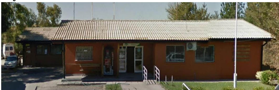
Fotografía N°1: CESFAM actual de Pencoche
