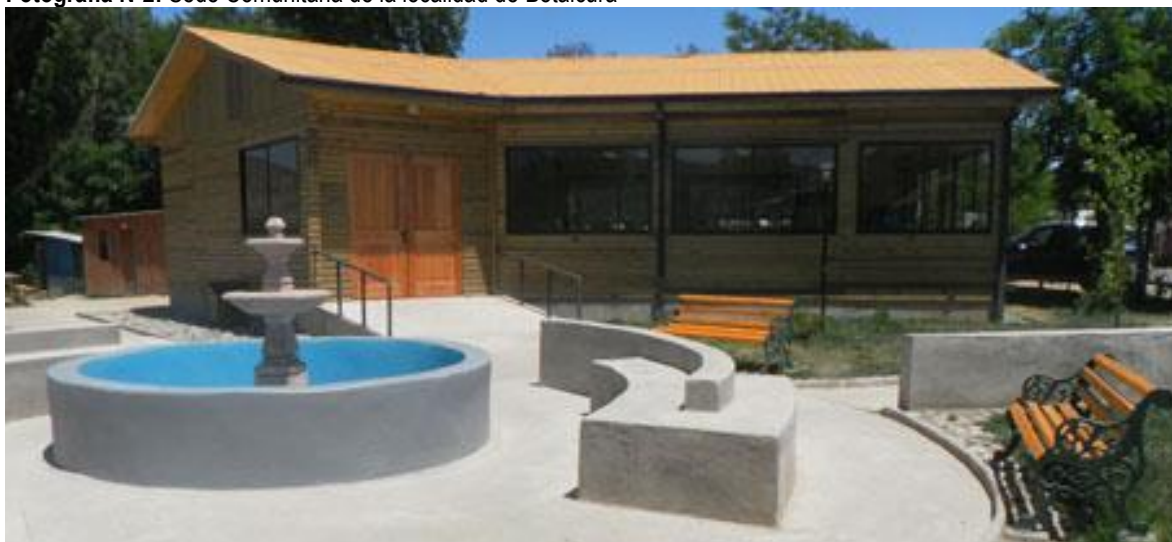
Fotografía N°2: Sede Comunitaria de la localidad de Botalcura
