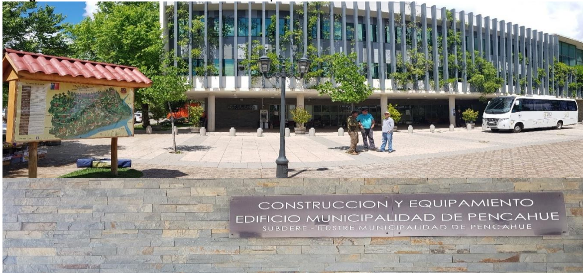
Fotografía N°2: Edificio Consistorial Ilustre Municipalidad de Péncahue
