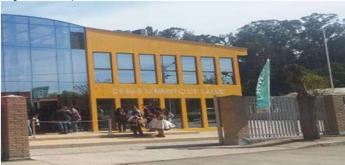
Fotografía N°1: Edificio Departamento de Salud Comuna de Chanco
