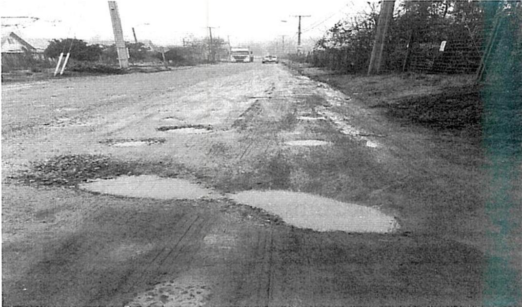
*SE APRECIAN DEFORMACIONES DELA PLATAFORMA AGUA SIN SALIDA NI PENDIENTE CERO SANEAMIENTO*
