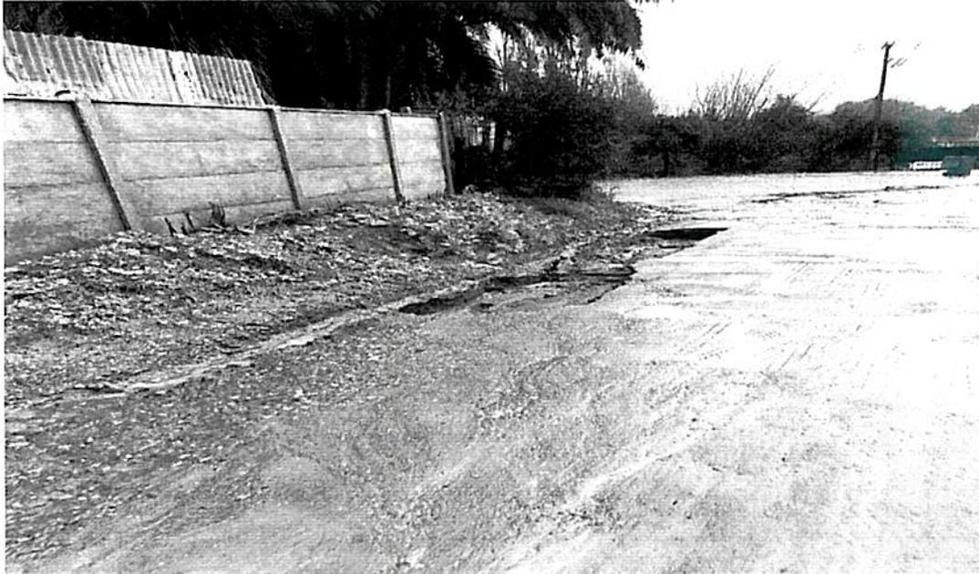
*plataforma undida, asentada sin compactacion ni material adecuado para los rellenos una vergüenza de trabajo para nuestra gente con plata del estado de todos los chilenos, LA EMPRESA SE LLAMA MAURICIO LEVI*
