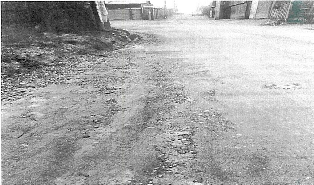
*PLATAFORMA SIN MATERIAL, RAZANTE DEL CAMINO BAJO LA COTA DE LOS CAMPOS COLINDANTES BUEN ANCHO PARA PROYECCION DE ASFALTO EJ. UN D.T.S.*
