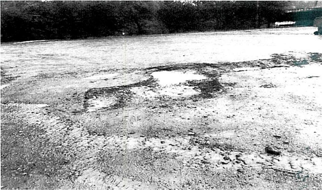
*Hundimiento evidente por falta de compactacion en el relleno estructural del nuevo alcantarillado, sin control de laboratorio sin capas de compactacion y supervisado por inspectores municipales (un robo)*
