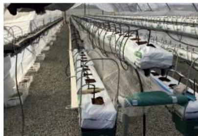
Foto 1. Estructura metálica de soporte central para el cultivo de frutilla en tres niveles.
