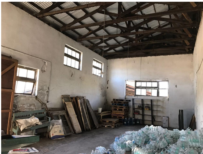
Vista de Sala previo a su habilitación
