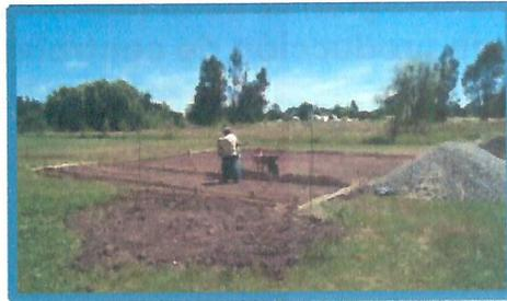
Foto 1. Despeje de terreno (izquierda) y demarcación para construir la obra civil que soportará los containers del laboratorio piloto de producción de insectos.
