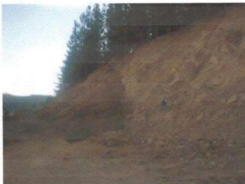
FIGURA N° 4-21 Derrumbe en Villa Estadio desencadenado por el sismo del 27 de febrero del 2010
