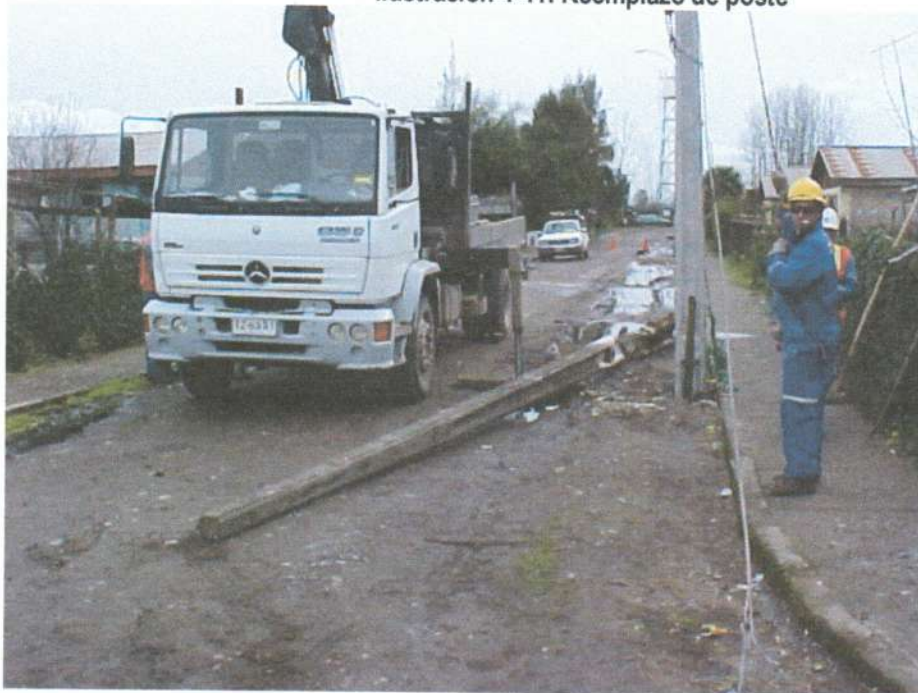
Ilustración 4-41: Reemplazo de poste
