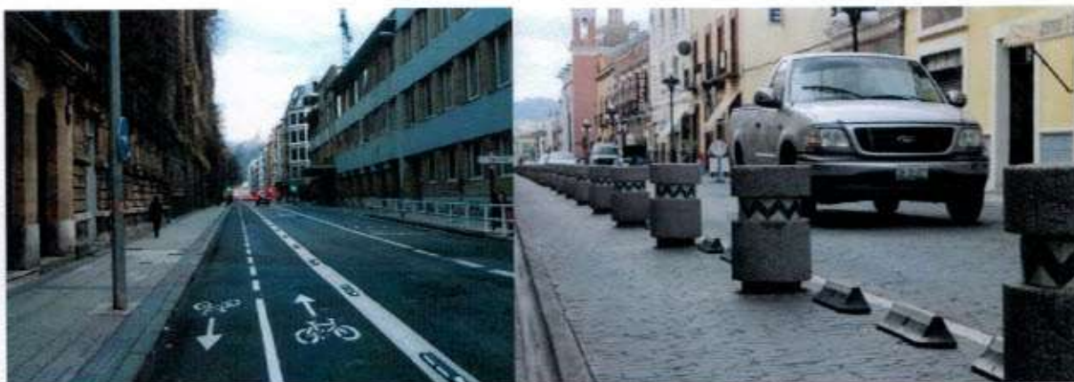
Fig.11. Ejemplos de ciclovías o ciclobandas integradas a la calzada, donde su ejecución consiste en su demarcación.
