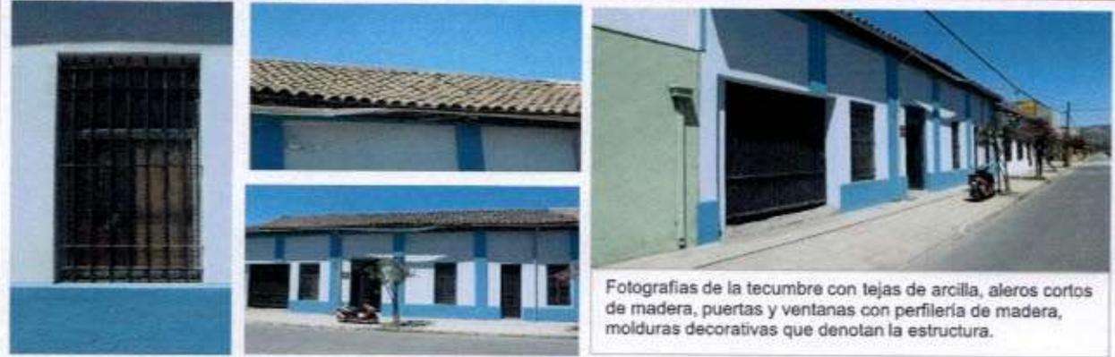
Fotografías de la tecumbre con tejas de arcilla, aleros cortos de madera, puertas y ventanas con perfilera de madera, molduras decorativas que denotan la estructura.
