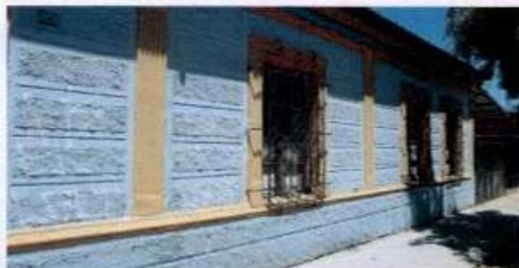
Fotografías de la tecumbre con tejas de arcilla, aleros cortos de madera, ventanas con perfilera de madera, molduras decorativas, ochavo y muros de adobe.
