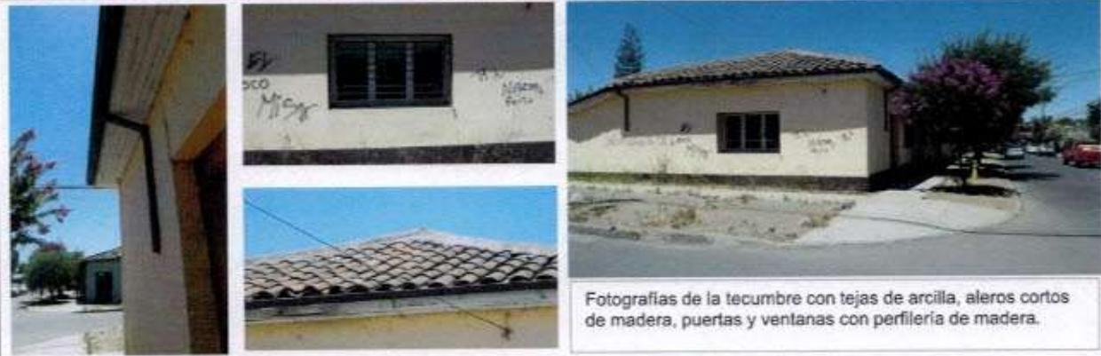
Fotografías de la tecumbre con tejas de arcilla, aleros cortos de madera, puertas y ventanas con perfilera de madera.
