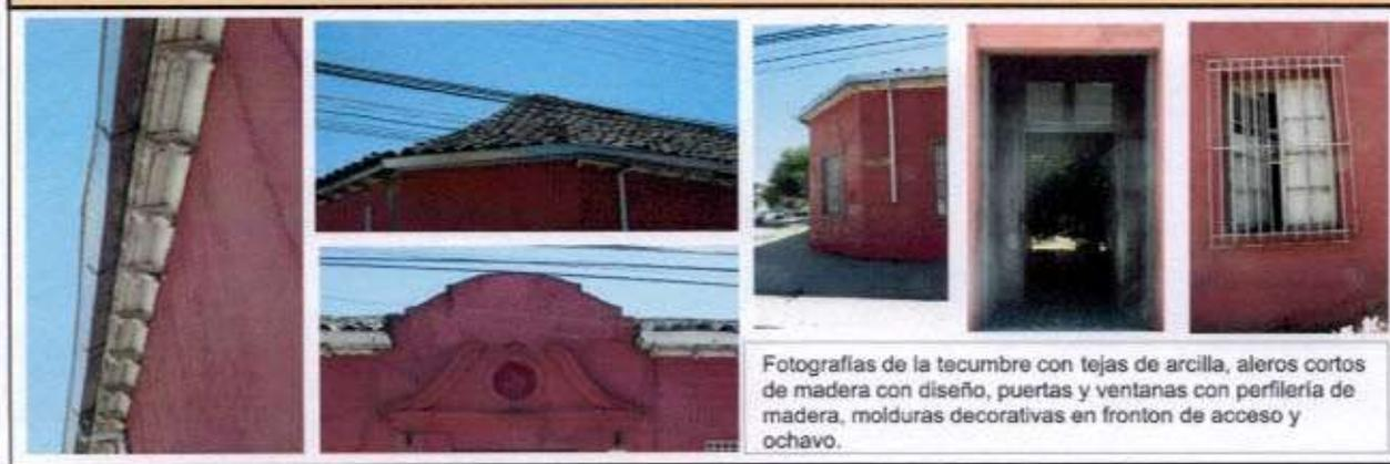
Fotografías de la techumbre con tejas de arcilla, aleros cortos de madera con diseño, puertas y ventanas con perfilera de madera, molduras decorativas en frontón de acceso y ochavo.
