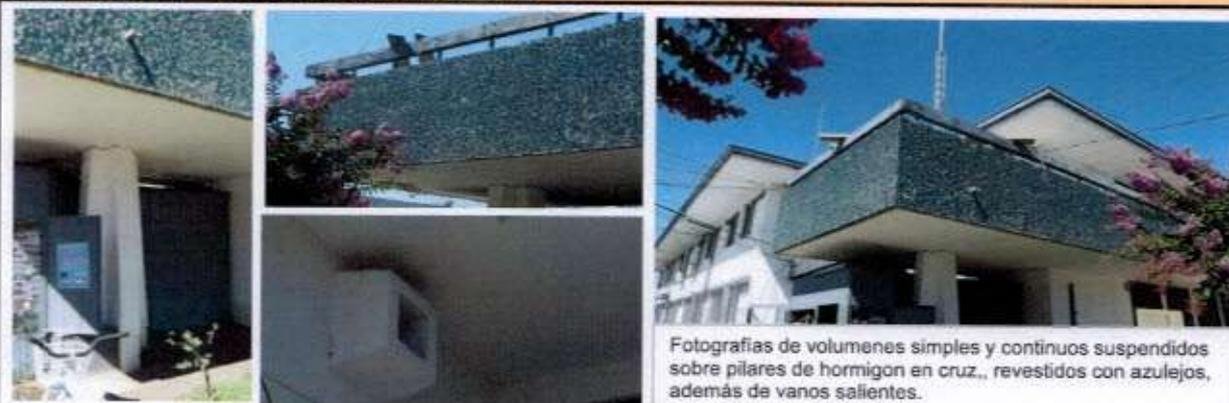
Fotografías de volúmenes simples y continuos suspendidos sobre pilares de hormigón en cruz, revestidos con azulejos, además de vanos salientes.
