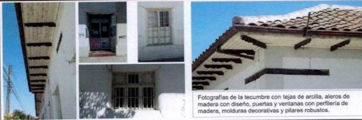
Fotografías de la tecumbre con tejas de arcilla, aleros de madera con diseño, puertas y ventanas con perfilera de madera, molduras decorativas y pilares robustos.
