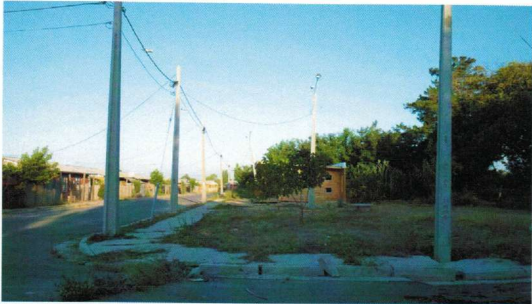
FOTO N° 6-4: Borde sur del loteo Don Sebastián, que muestra a la derecha de la imagen el límite del área consolidada sur de este sector de la localidad
