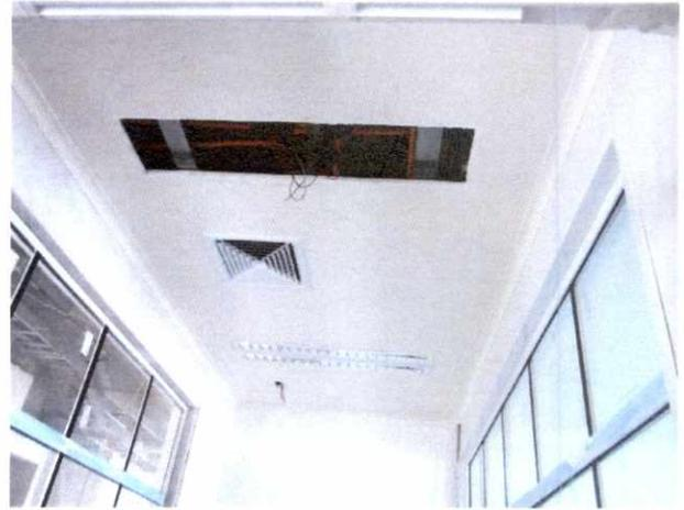
Fotografía N° 14: Vista de avance en instalación de equipos fluorescentes en local de Química clínica (A-130).
