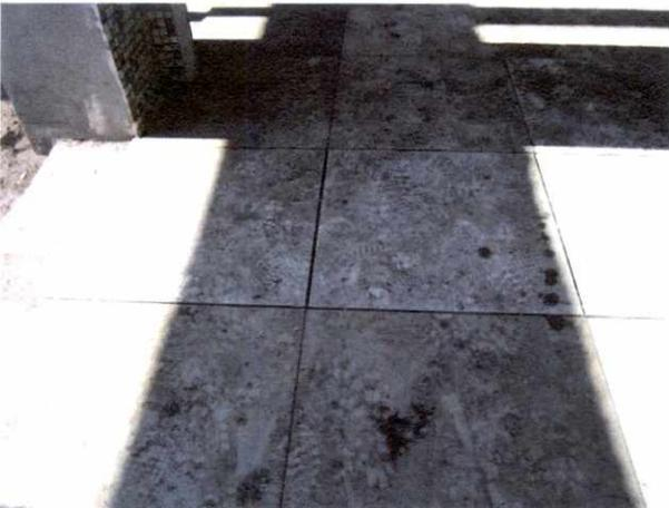
Fotografía N° 27: Vista de terminación dispareja de pavimento interior, del tipo porcelanato antideslizante en sala de espera.
