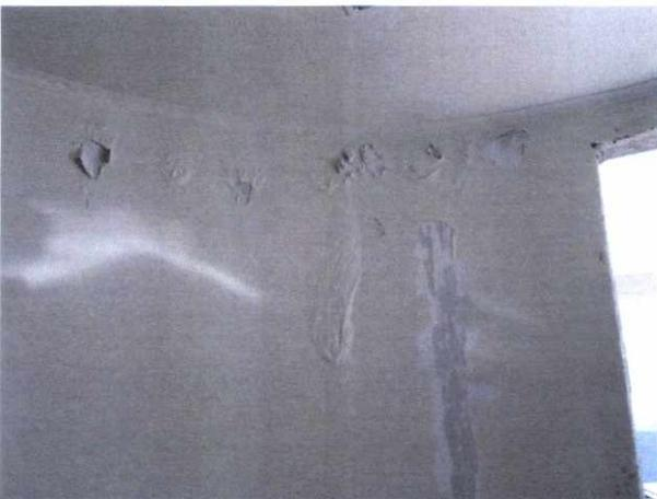
Fotografía N° 29: Detalle del deterioro de la película de pintura aplicada al interior de la Sala de Rehabilitación (A-143).
