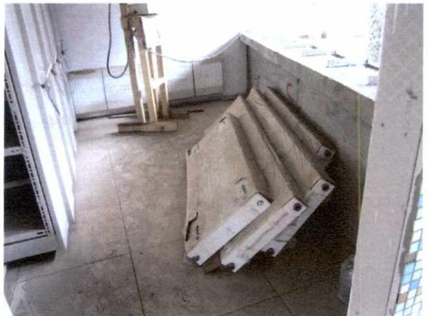
Fotografía N° 18: Detalle de instalación de archivadores del tipo "Full Space" y radiadores sin estar terminadas las superficies de piso y muro.
