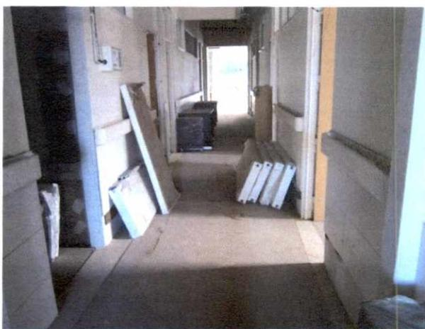
Fotografía N° 2: Detalle de acopio de radiadores "Khöne" apilados en pasillos.
