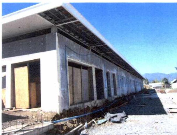
Fotografía N° 3: Vista fachada costado sur sin la instalación de las bajadas de aguas lluvias de PVC Ø 110.
