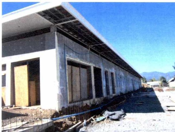
Fotografía N° 9: Vista de alero fachada sur sin revestimiento de acuerdo a la solución graficada en la lámina COL-ARQ-C-LAM-ESC. Fecha: 09-04-15.
