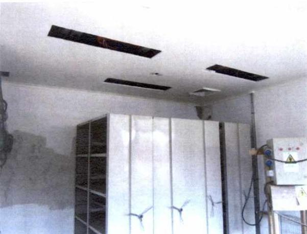
Fotografía N° 17: Vista de archivador del tipo "Full Space" instalado sin estar terminadas las superficies de muros.
