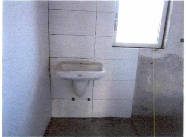
Fotografía N° 16: Detalle tipo de instalación de lavamanos mural, sin pedestal, sin encontrarse aplicado el fragüe pertinente.
