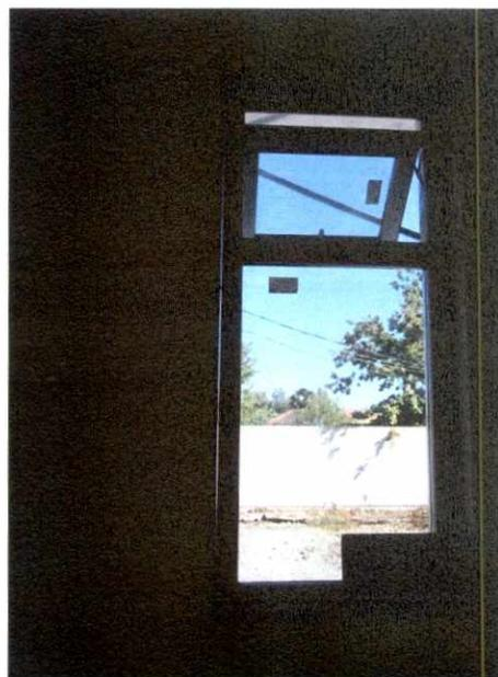
Fotografía N° 36: Detalle de vanos de ventana con descuadros en su sección.
