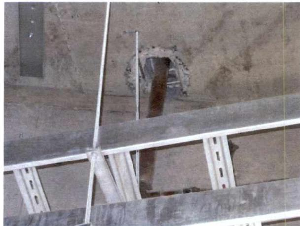
Fotografía N° 24: Vista de intervención de losa para paso de tubería.
