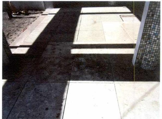
Fotografía N° 28: Vista de terminación de pavimento con diferencias en calce, alineación y nivelación de las piezas.
