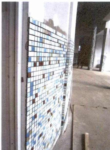
Fotografía N° 32: Vista de instalación y terminación de mosaico de porcelanato en paramentos verticales.
