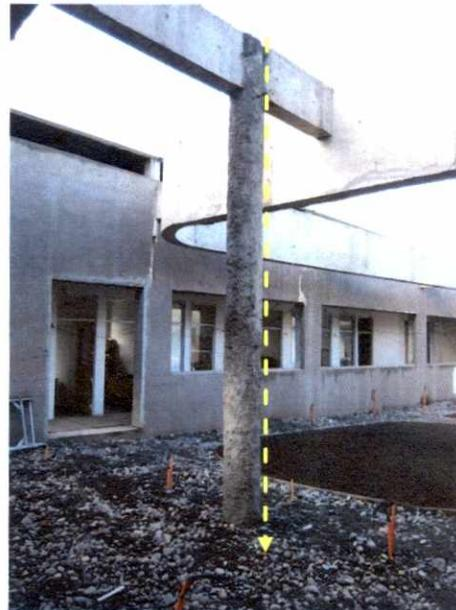
Fotografía N° 22: Detalle de pilar circular situado en patio principal que presenta reparación por pérdida de geometría en su sección.
