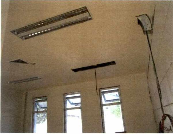
Fotografía N° 13: Detalle de avance en instalación de equipos fluorescente en recinto de Cafetería general (A-154).
