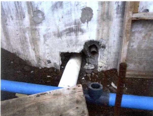
Fotografía N° 23: Detalle de intervención de muros en instalación de tuberías.
