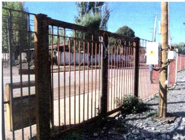
Fotografía N° 31: Detalle de portón metálico sin capa de anticorrosivo de protección.
