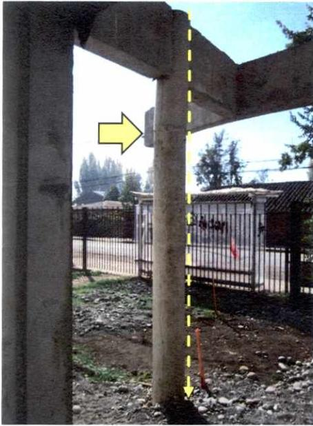
Fotografía N° 19: Detalle de pilar circular en acceso a recinto con desaplomo.
