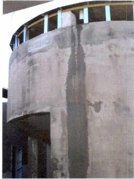
Fotografía N° 6: Vista de fachada en patio de rehabilitación sin tubería de bajada de aguas lluvias de PVC Ø 110. Fecha: 14-04-15.
