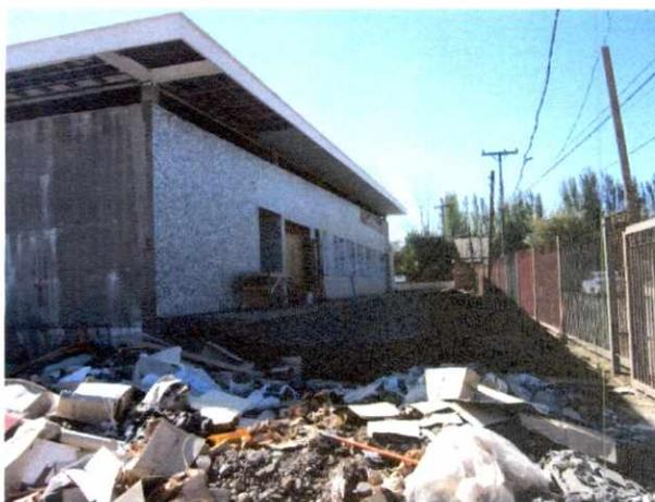
Fotografía N° 10: Vista de alero fachada oriente sin revestimiento completo, de acuerdo a la solución graficada en la lámina COL-ARQ-C-LAM-ESC. Fecha: 09-04-15.
