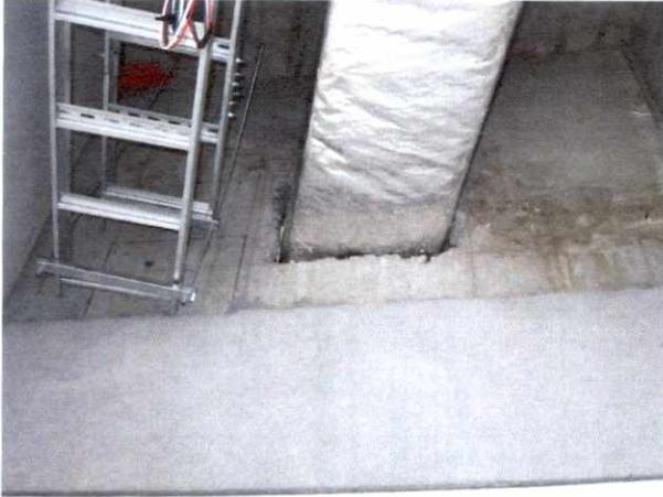
Fotografía N° 25: Detalle de intervención en muro para dar paso a ducto de aire.
