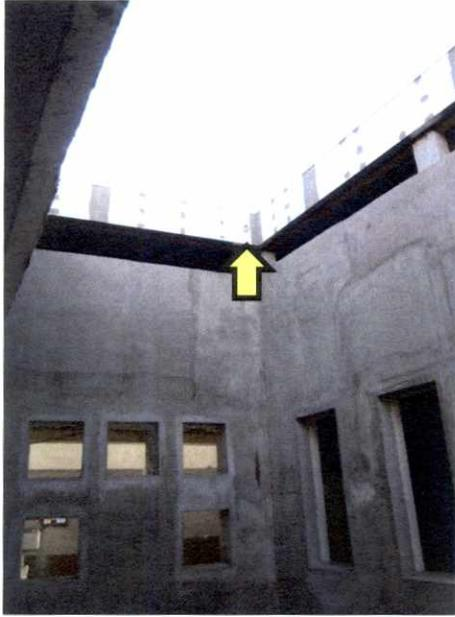
Fotografía N° 5: Detalle de boca para instalación de bajada de aguas lluvias en patio interno. Fecha: 14-04-15.
