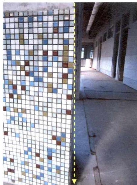
Fotografía N° 34: Detalle de plomo de superficies de muro, en instalación de mosaico de porcelanato.
