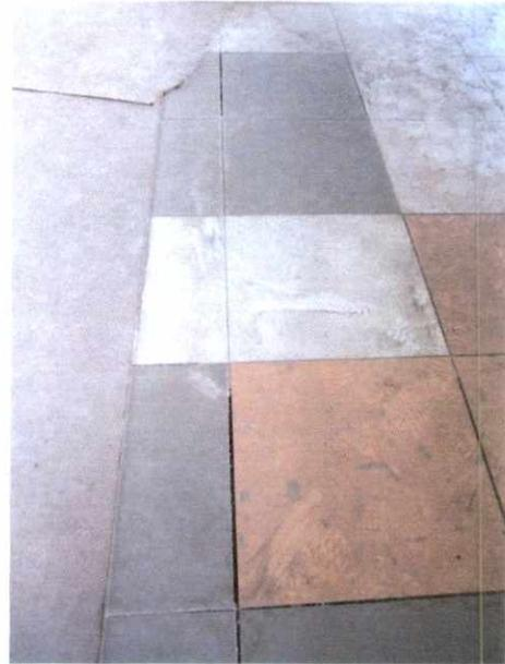
Fotografía N° 26: Detalle de cantería variable en instalación de porcelanato, sector de espera.
