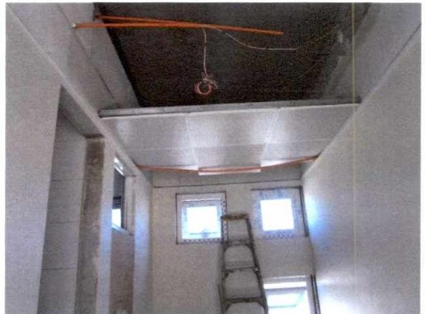
Fotografía N° 8: Detalle de muestra piloto de cielo modular metálico instalado en faena, en zona de pasillos contiguo al baño de personal (A-166). Fecha: 09-04-15.
