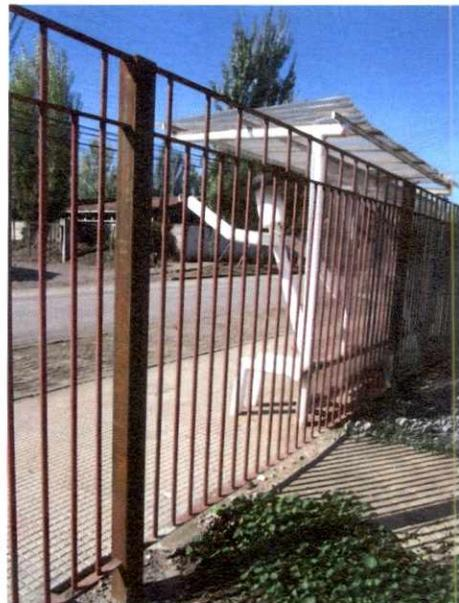
Fotografía N° 30: Vista de cierre perimetral, instalado y expuesto a la intemperie, sin contar con la debida aplicación de anticorrosivo en maestranza.
